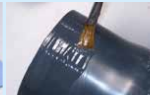
Kleber beidseitig auftragen
