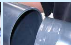
zu verklebende Teile verbinden
