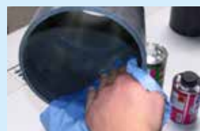
Muffenstück von innen reinigen
