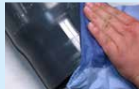
Rohrstück von aussen reinigen
