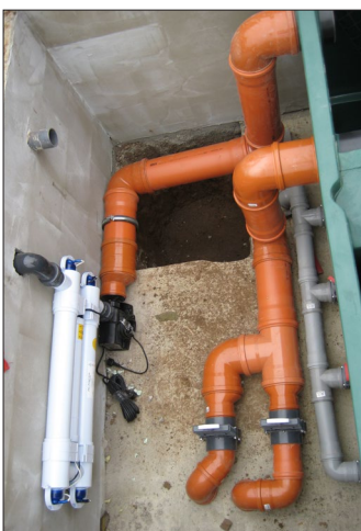
Ein- und Ausgang / Schwerkraftversion
