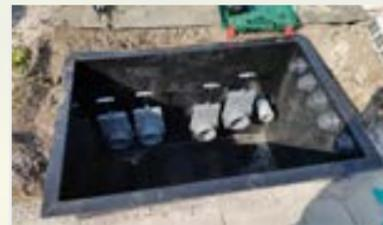
Beispielinstallation als Sammelkammer bei einer Schwerekraft-/Pump-Version
