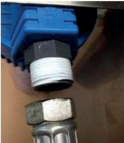
2. Verschrauben Sie den Schlauchanschluss mit dem Vorfilter.
