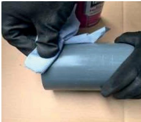
2. Reinigen Sie die zu verklebenden Stellen auf der Innenseite der Anschlussmuffe und auf der Außenseite der Rohre mit Kunststoffreiniger.
