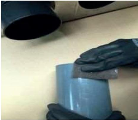
1. Rauen Sie die Anschlussmuffe (schwarz) auf der Innenseite und die Rohre auf der Außenseite an den überlappenden Stellen in eine Drehrichtung an.
